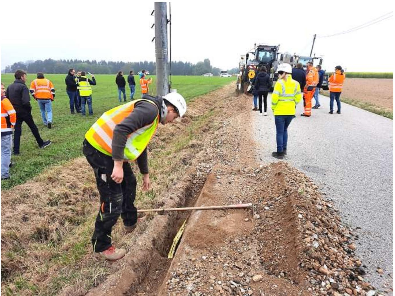
Mit Spezialgerät aus Österreich werden derzeit die Hauptstränge an Leerrohren verlegt, in die in einem nächsten Arbeitsschritt dann die Glasfaser eingeblasen wird.
