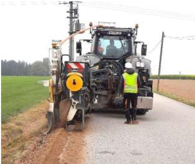
Eine Spezialmaschine verlegt die Leerrohre.
